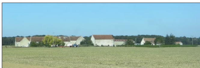
Vue d'une ferme isolée en Seine-et-Marne
